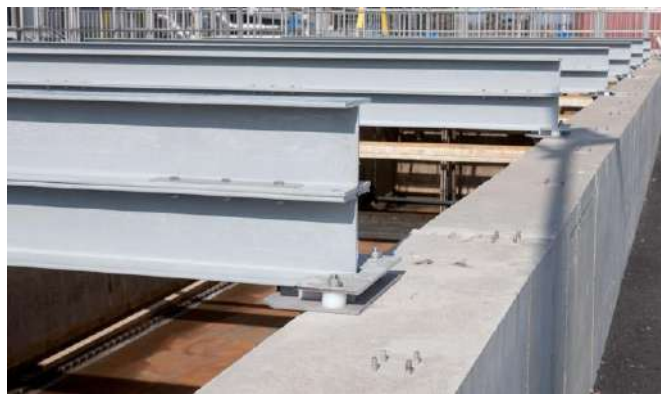
Structures support pour les couvertures.
