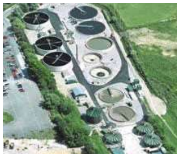
Station d'épuration municipale d'Ernesettle, Grande-Bretagne
